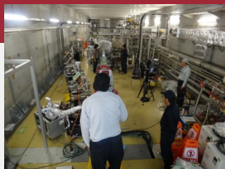
3. ティルティングレベル(N3), トータルステーション(NET05X), レーザトラック(T3)を用いた電磁石精密設置
