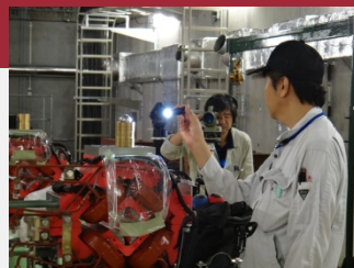
3. ティルティングレベル(N3), トータルステーション(NET05X), レーザトラック(T3)を用いた電磁石精密設置
