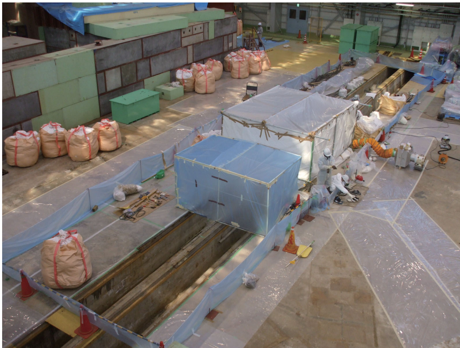
ピット内放射化物回収現場写真
