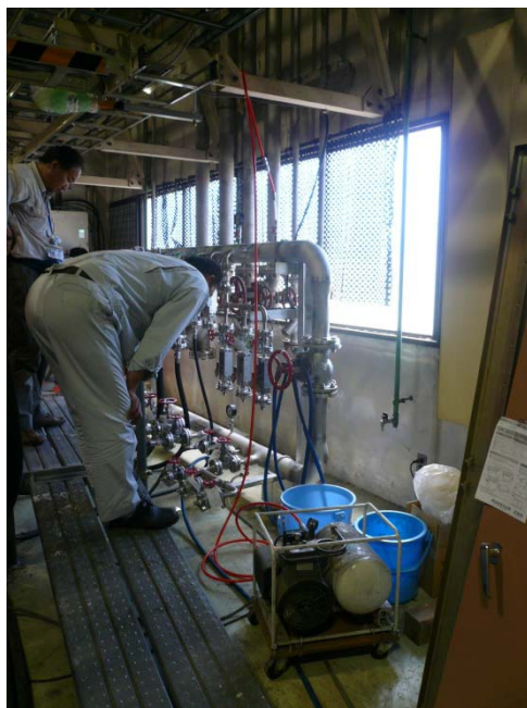
ヘッダー水抜き作業
