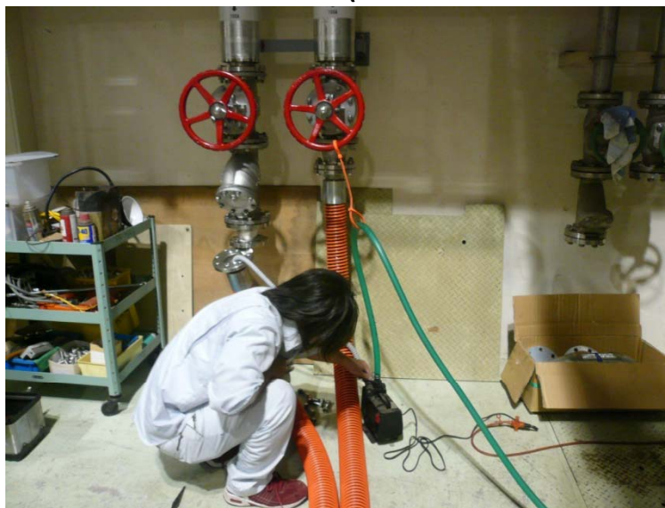
ホース内の水抜き(80Aホース 約40m x 2)
