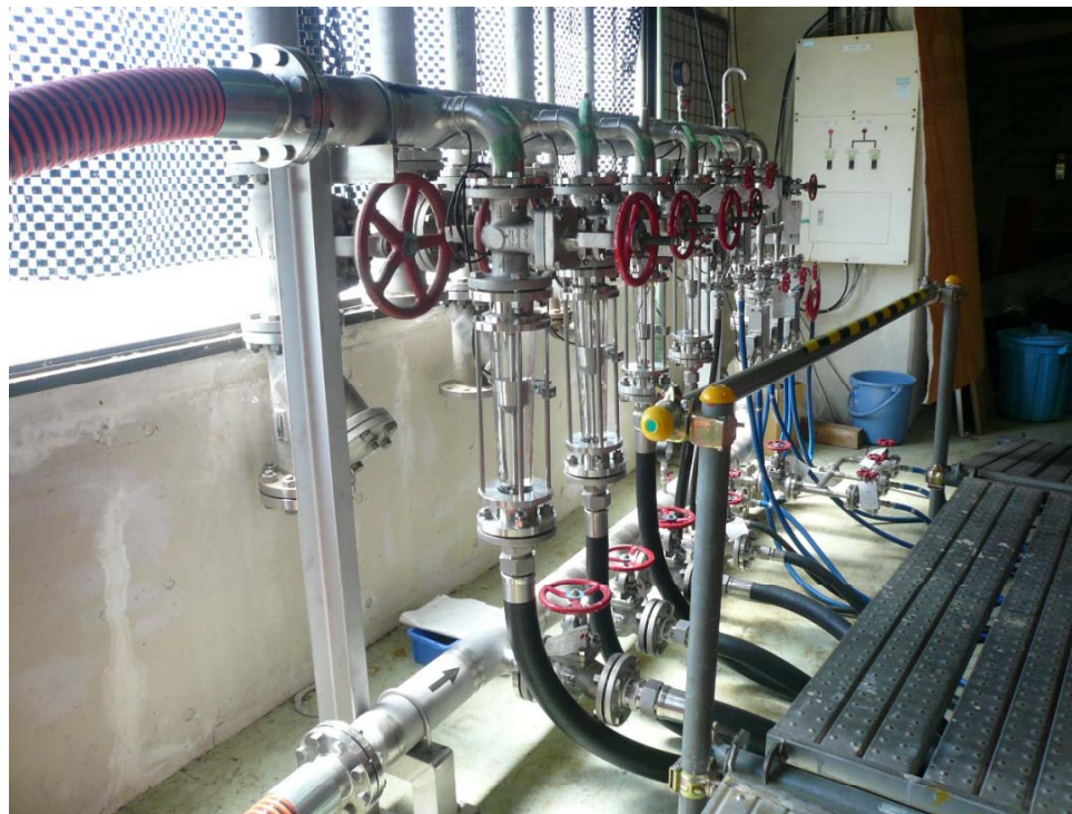
ホース内の水抜き(80Aホース 約40m x 2)
